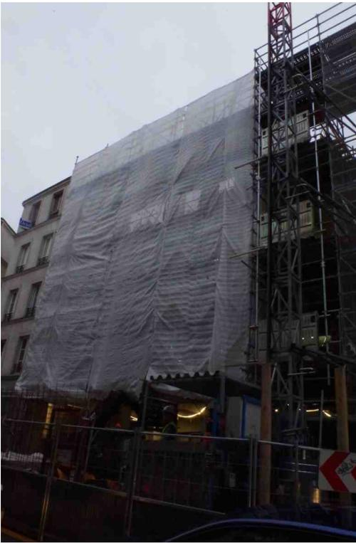
Vue de la façade durant les travaux en décembre 2019. Une bâche la recouvre, mais on voit à travers que seule la façade est conservée et que le rez-de-chaussée a commencé à être bétonné.
